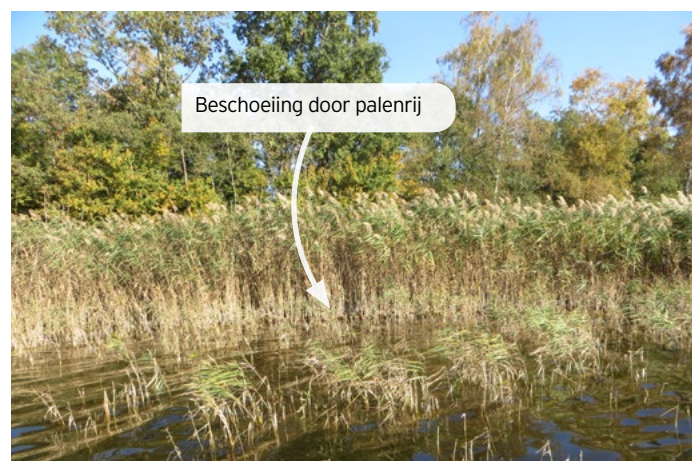
figuur 3.1 Palenrij die grotendeels onder waterlijn staat zorgt voor behoud waterriet. Door ganzenvraat is dit deel van de rietkraag inmiddels verslechterd zodat de beschoeiing zichtbaar is geworden.
