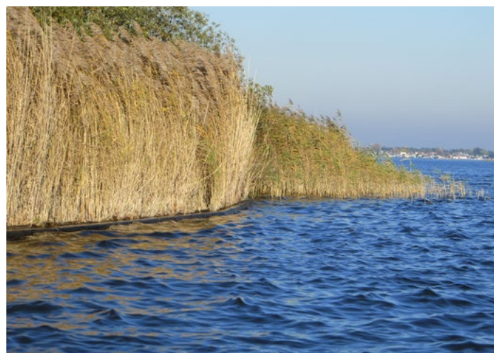
figuur 2.2 Beschoeiing vermindert de kwaliteit en de breedte van het waterriet. Duidelijk zichtbaar is hier het kleine resterende stukje op de plek waar de beschoeiing onderbroken is. Hier is het waterriet veel breder en heeft de noodzakelijke uitloopzone.
