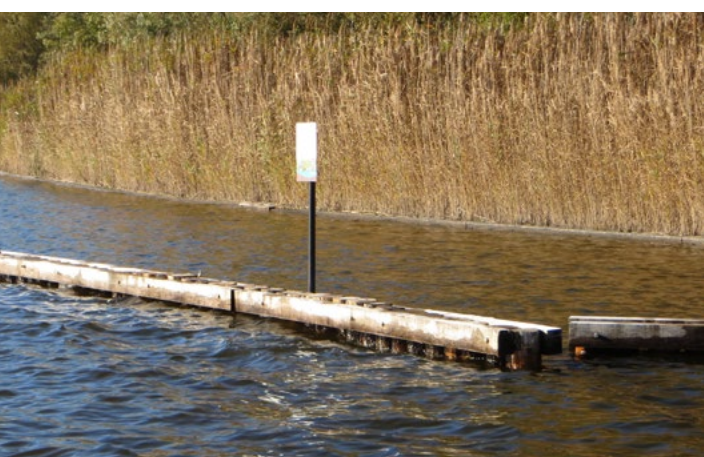
figuur 2.1 Aangelegde dubbele beschoeiing op veel eilanden in Loosdrecht. Onder water zijn gaten in de beschoeiing gemaakt. Het is onduidelijk of dit voldoende is om de uitloopzone weer tot ontwikkeling te laten komen.
